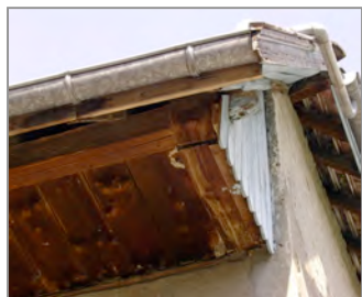
Détails: les lambris de dessous de toits
